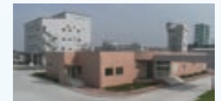
呉羽(常熟)フッ素材料有限公司 工場
