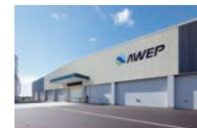
クレハ建設株式会社 2020年度施工実績例：AWEP小名浜バイオマス 発電事業木質ペレット・PKS保管所
