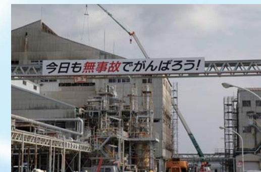
いわき事業所 復旧作業
