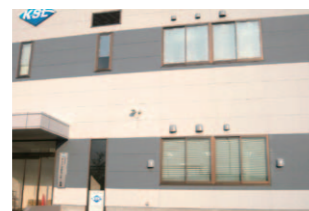
省エネ対策 安価養生シートの利用
