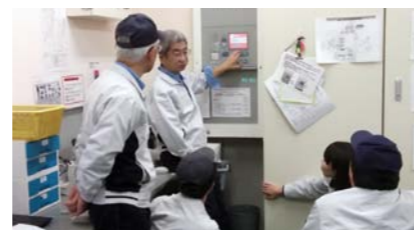
防災監視盤操作説明
