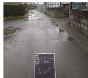
町道・工場排水路整備 着工前
