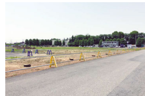
新工場の建設予定地
