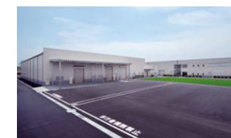
整備後の屋外通路
