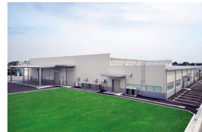
完成した複合棟外観
