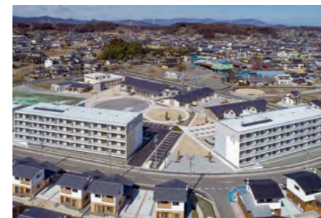
勿来酒井地区復興公営住宅 (優秀工事施工者受賞)
