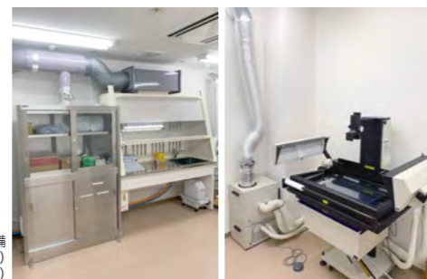
呉羽総合病院で導入した設備 ドラフトチャンバー(左) 標本撮影台(右)
