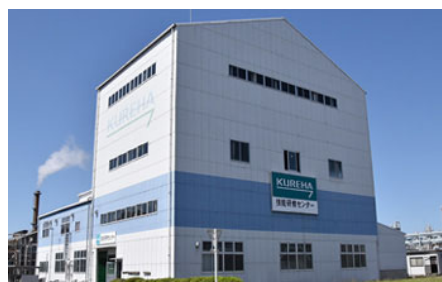
技能研修センター
