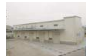
環境対策(保管倉庫設置)
