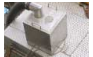
カールドルから局所排気ライン設置
