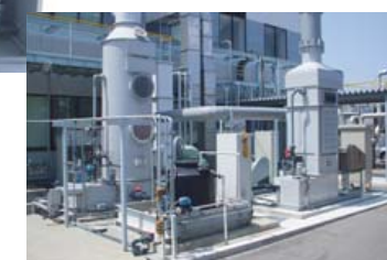
酸性ガス処理設備の除害塔を2基に増設
