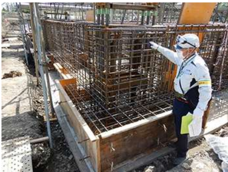
建築工事基礎 社内検査
