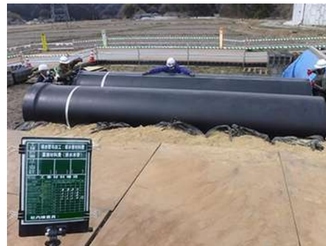
土木工事導水管布設工 社内検査
